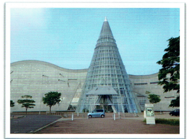
久慈市文化会館アンバーホール 外観
