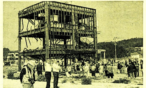
(追悼のモニュメントとなった防災センター)
